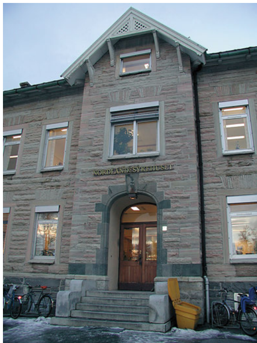
FIGUR 4. I Rønvik asyl fra overgangen mellom 1800- og 1900-tallet er tradisjonell arkitektonisk dekor sløyfet i eksteriøret, bortsett fra hjørner og omramminger i rettlinjert saget marmor. Det er proporsjonene og spillet i fasadesteinen som gir bygningen karakter. Foto Paul Bratland Pincus 2005.
