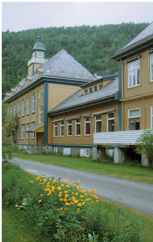
FIGUR 5. Vensmoen sanatorium ble plassert i et område med gunstig klima for å kurere tuberkulose. De store kurbhallene, der pasientene var både ute og inne på samme tid, var viktig i behandlingen. Det samme var det store parkanlegget på sørsiden av bygningen – der pasientene skulle spasere for å få mosjon og frisk luft. Arbeid i hagen eller parken var en del av behandlingen. Foto Ingebjørg Hage 2005.
