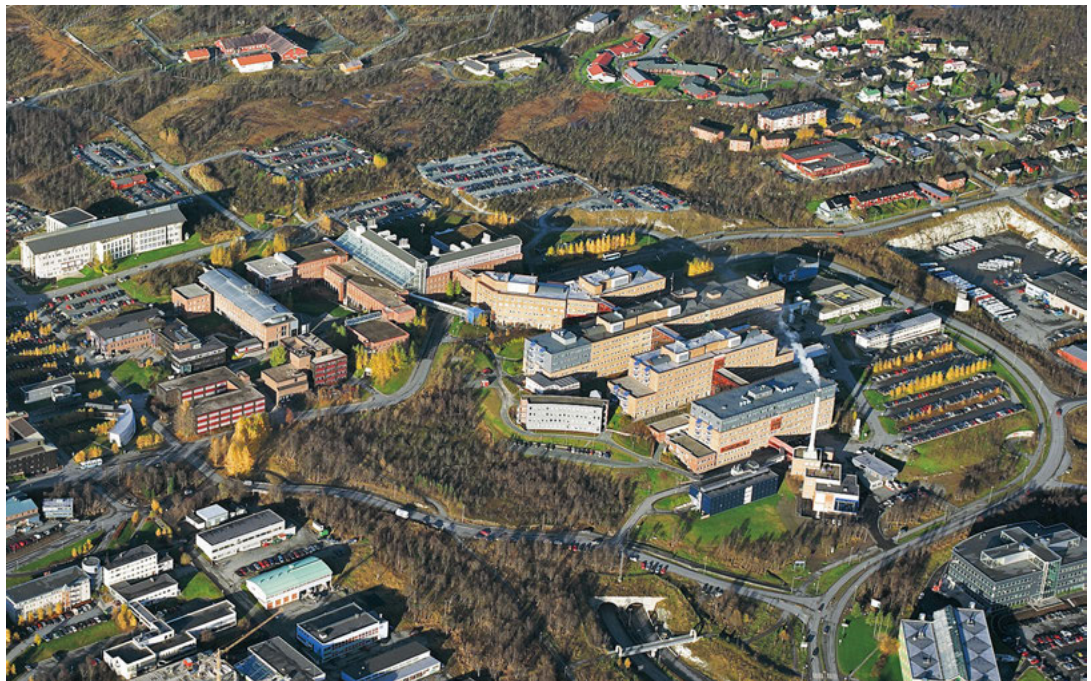
FIGUR II. Medisin og helseinstitusjonene ligger nord på universitetsområdet i Tromsø – et stort anlegg, nærmest en by i byen. Terrengtet er skrånende og faller mot øst og sjøen. Medisin og helsefagsbygningen (MH) ligger øverst til venstre og Universitetssykehuset Nord-Norge (UNN) nedenfor, supplert med en rekke tilbygg, som helikopterstasjon og sykehotell. Foto To-Foto 2004, utsnitt.
