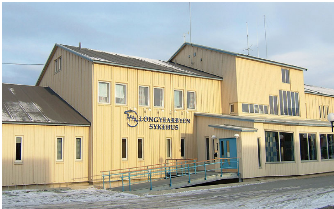
FIGUR 12. Longyearbyen sykehus, Svalbard. I arkitektens presentasjon av bygningen blir det framhevet at permafrost, sterk vind og snødrift i et arktisk område krever spesielle løsninger. Bygningen har en enkel og økonomisk grunnform som har i seg noe av den røffe frodigheten en finner i gamle bygninger og konstruksjoner på Svalbard. Foto Leif Maliks, utlånt av Helse- og omsorgsdept.
